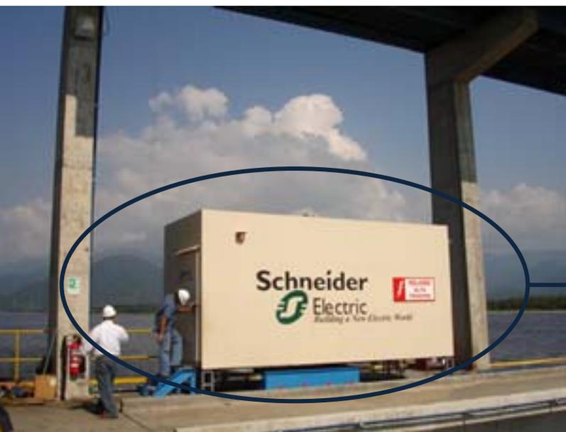
Subestación 400 Kva 13200 / 460 / 220 Vac para operación del muelle de Carbones del Caribe en Río Córdoba Magdalena, fabricada para SCHNEIDER ELECTRIC.
