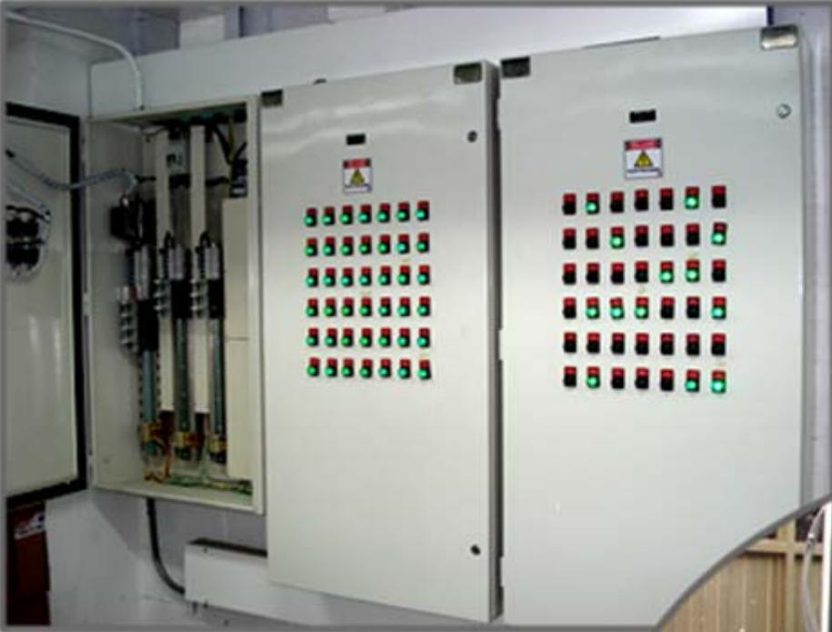
Los tableros de **CONTROL AUTOMÁTICO DE ILUMINACIÓN** permiten ejecutar el control de este proceso por medio de tareas programadas y controladas a través de una interfaz *software* y *hardware* desarrollada específicamente para solucionar las necesidades de su instalación.
